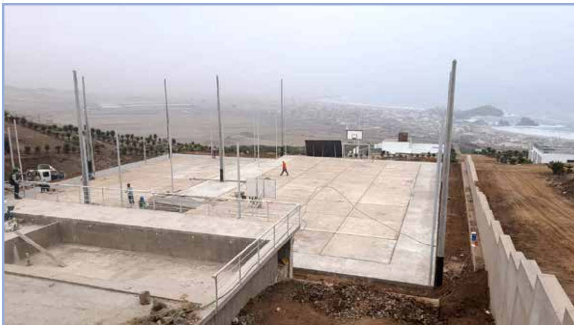
Instalación de postes para la colocación de mallas de 6m de altura
