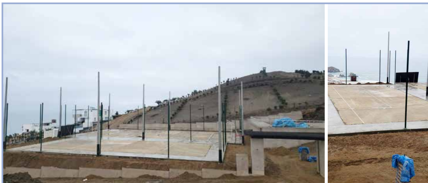
Instalación de postes de iluminación en canchas de frontón, tenis y multiusos
